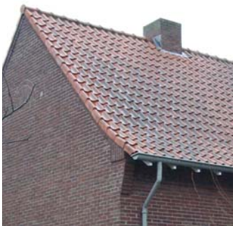
Overstekken en schoorstenen
